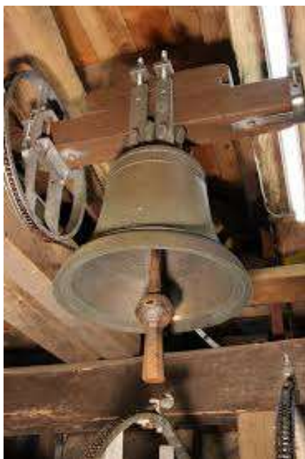
7.kép Tölgyfából készült harang lengőszerkezetek felülütős harangozásra kialakítva.
